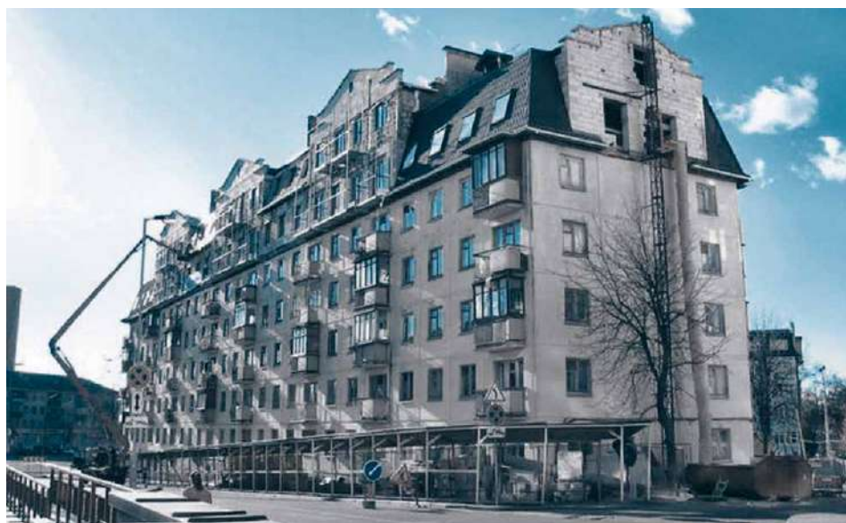
Надстройка двухуровневой мансарды на панельный дом
