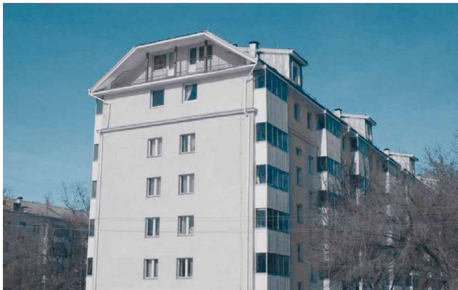
Дом после реновации, выполненной чешской компанией, г. Уфа Надстроено два этажа, разместились 16 двухуровневых двух- и трехкомнатных квартир
